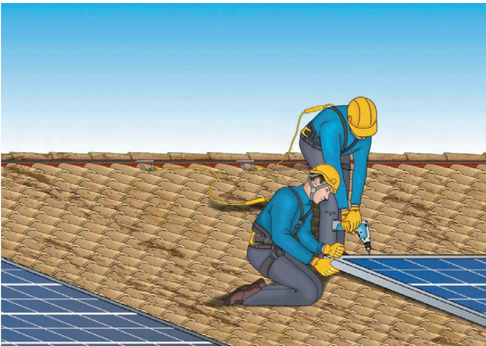
Figura 4 - Esempio di ancoraggio lineare permanente rigido
